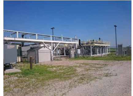
写真10 バイオアスファルト製造のパイロットプラント
