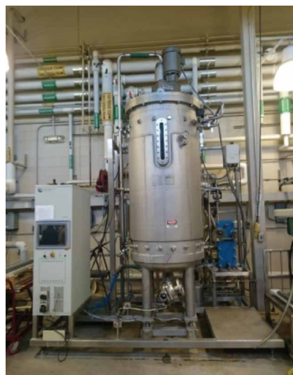
写真8 1トンスケールの発酵タンク
