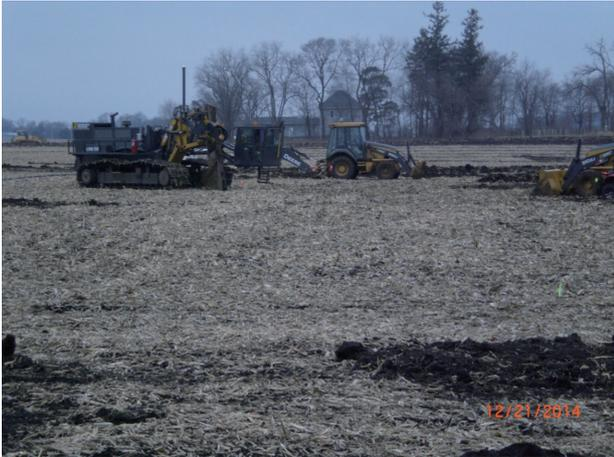
写真5 アルバー農場でのタイル(暗渠)敷設作業 遠くに見えるトラクターで農地にプラスチックチューブの暗渠を敷設していく。農地の状態や排水水位によって、深度を調整して、敷設される。
