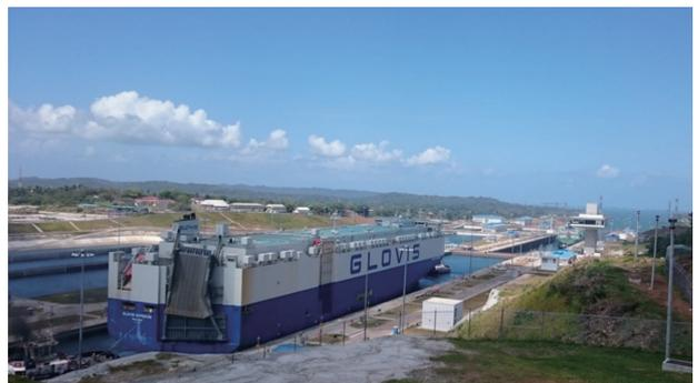
パナマ運河のミラフローレス開門の右側が高水位側、左側が低水位側になっています。写真1では、水門が閉ざされていて水位の差がはっきりわかります。写真2では2レーンともに高水位側から船が入ってきています。開門に船舶が入ると後方の水門が閉ざされ、開門中の水が排水されて水位が下がっているのが写真3でわかります。奥のレーンでは、レーンをはさむように敷かれたレールを機関車が走り船舶を曳いて水門を通過していっています(写真4)。手前のレーンの船舶も開かれた水門を通過して(写真5)、低水位側へ進んでいきます(写真6)。さらに前方にもう一段の開門があり、それを通過すると太平洋
