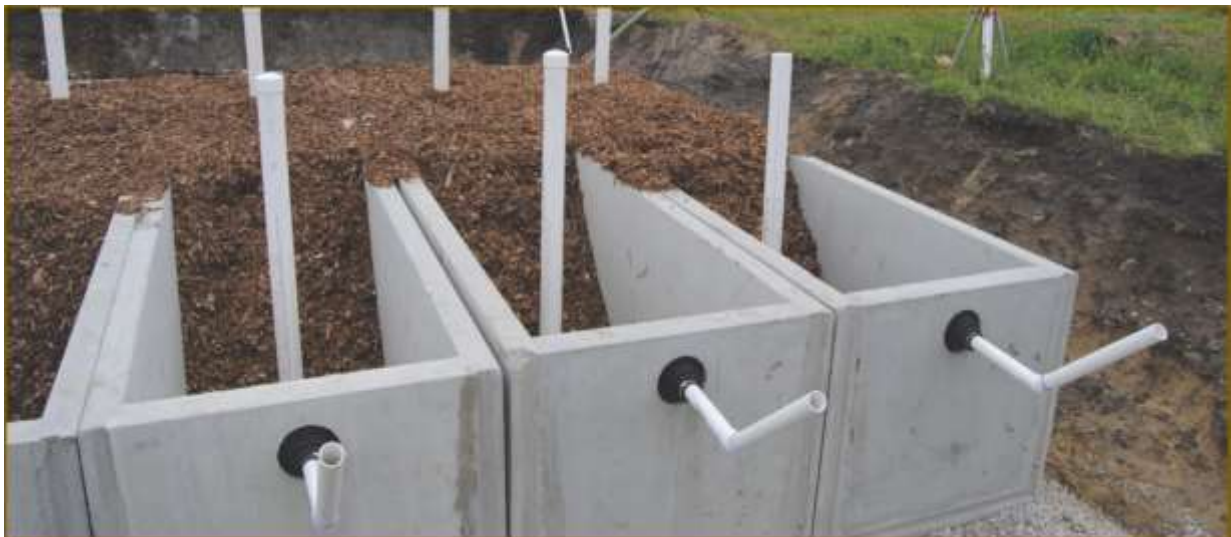
画像：水路に堆積する硝酸塩窒素を減少させるために使用するバイオリクター
