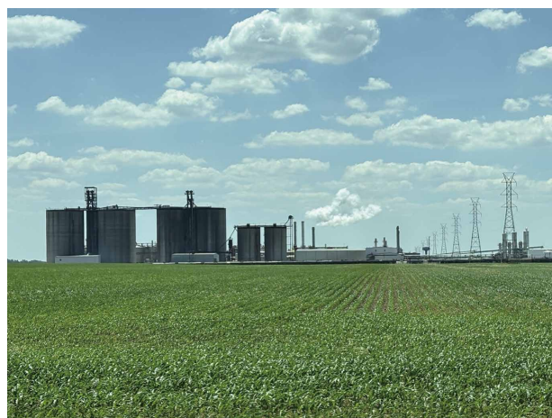
写真2 Marquis社のエタノール工場
