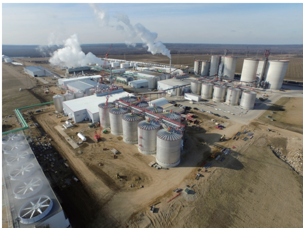
図13 マルキース・エネルギー社ヘネピン工場全景
