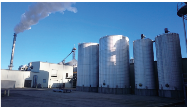
スラリー製造タンク(奥の太い2本)と蒸留塔(手前の細い2本)
