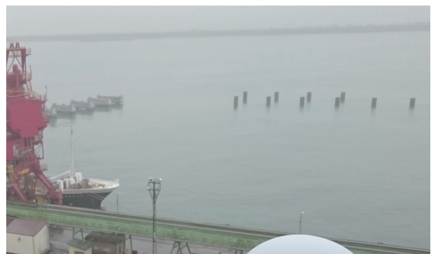
写真12 釧路港拡張工事の様子
