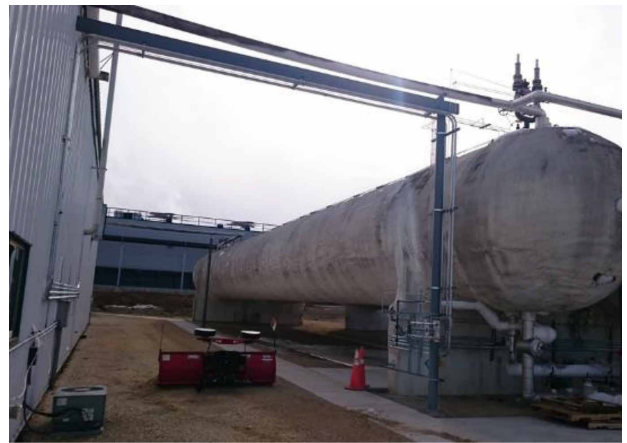
写真8 エタノールの併産物として生成するCO 2 を回収するタンク
